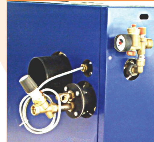
Sicherheitsgruppe SG nicht vergessen , hier am Beispiel varioflame. Auf der Brennerseite am Kessel befindet sich eine 1" Muffe für die Sicherheitsgruppe SG!
