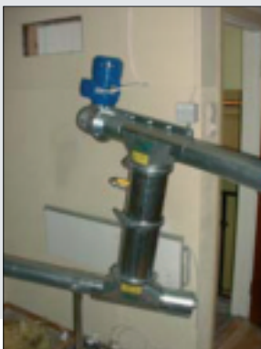
Bild 21. Transportschneckenverbindung
