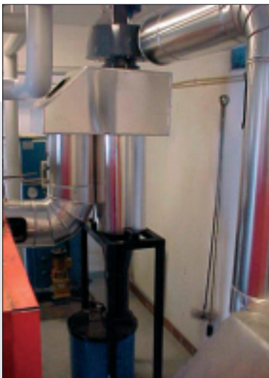
Bild 30. Zyklon mit Sammelbehälter
