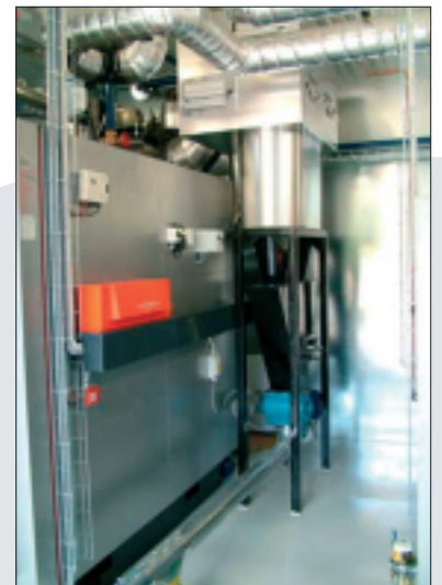
Bild 31. Zyklon mit Zellradschleuse
